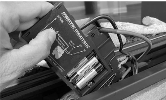
5. Remplacez le couvercle des piles, faites glisser le module de commande dans le foyer et serrez la vis à oreilles argentée.
