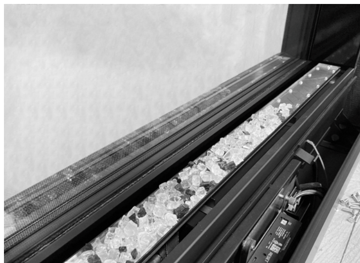
L'installation partielle du verre transparent et écrasé
