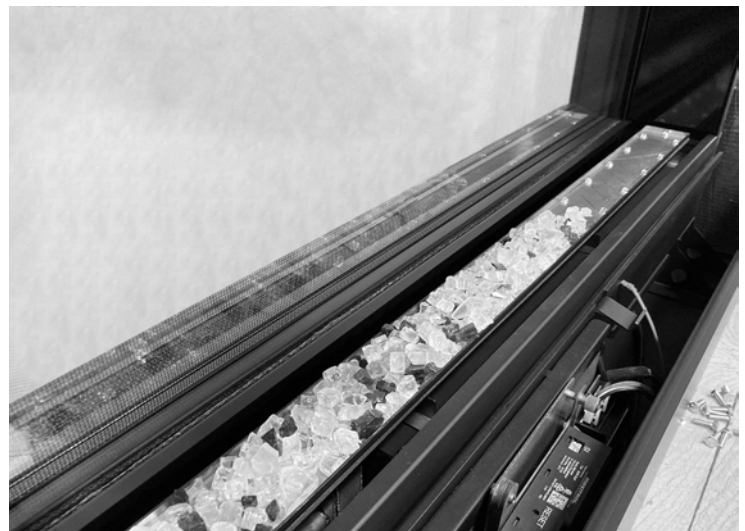
L'installation partielle du verre transparent et écrasé
