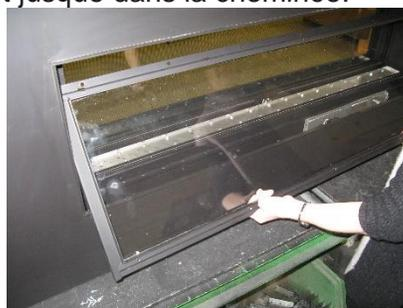
2. Soulevez l'ensemble de châssis de verre de façon à ce que le fond de l'ensemble de châssis de verre efface le fond de l'ouverture du foyer.
