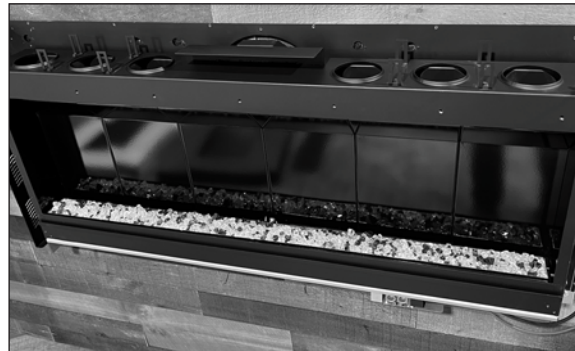
L'installation complète du verre transparent et écrasé
