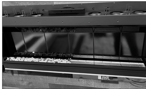
L'installation partielle du verre transparent et écrasé
