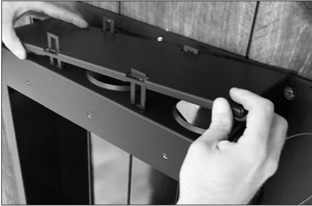
L'attache du devant de la porte de sûreté engagée sur le support
