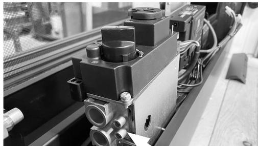
4. Confirmez que la pression d'entrée du gaz (prise de pression supérieure sur la vanne) est comprise entre 5,5" CE et 10,0" CE. pour le gaz naturel et 11" w.c. à 13" w.c. pour propane. Si la pression n'est pas dans ces paramètres, corrigez tout problème de pression d'alimentation en gaz avant de poursuivre la conversion. Fermez le robinet de pression.
