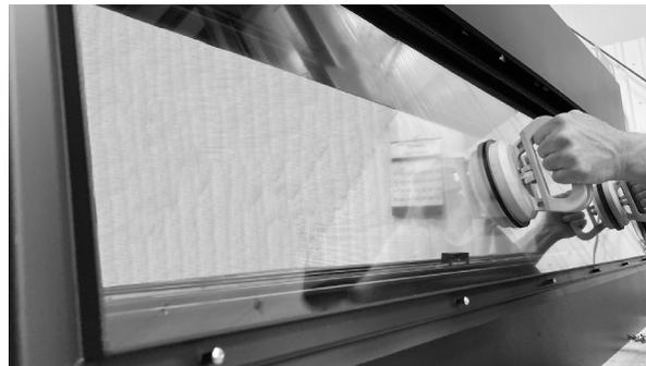
2. Soulevez l'assemblage du cadre en verre de sorte que le bas de l'assemblage du cadre en verre dépasse le bas de l'ouverture du foyer.
