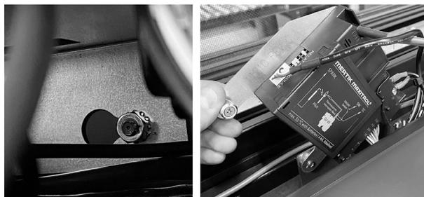
3. L'ensemble du robinet de gaz est sur des connecteurs flexibles qui vous permettent de le soulever hors du foyer, comme illustré. Assurez-vous que tous les fils et les conduites de gaz sont libres lorsque vous retirez l'assemblage du robinet de gaz du foyer.
