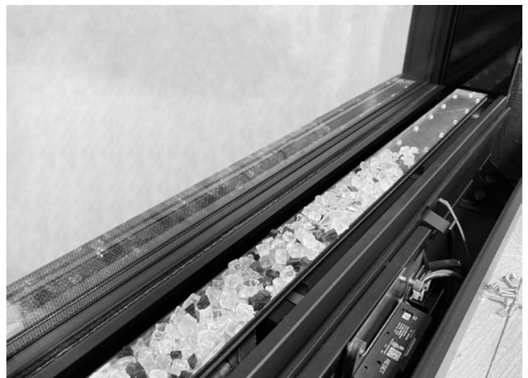
Brûleur verre Média partiellement installé
