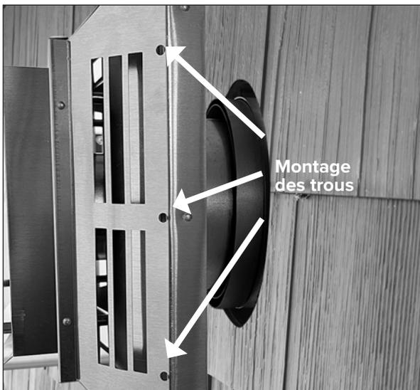
5. Faites glisser la terminaison d'évent (bouchon) dans le renforcement du parement (ou le protecteur de parement en vinyle) jusqu'à ce qu'il soit en butée.
