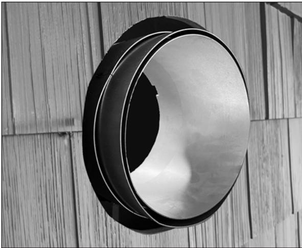
3. Installez la terminaison de ventilation horizontale (capuchon de ventilation). Assurez-vous que la flèche sur le capuchon (le cas échéant) pointe vers le haut et reconfirmez que toutes les exigences d'emplacement du capuchon d'évent de la page 17 et les exigences du fabricant de l'évent sont respectées.
