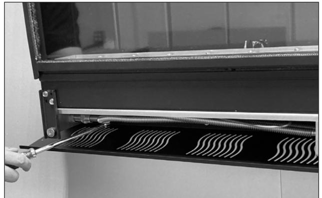
4. Retirez les 2 vis cruciformes des bords extérieurs du panneau extérieur inférieur.
