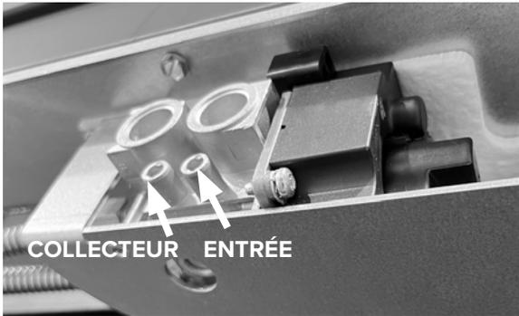
3. Installer un manomètre sur la prise de pression de sortie de la vanne.
