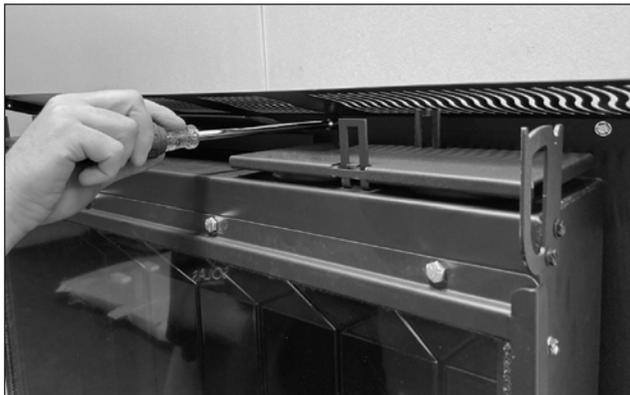
2. Installez ensuite le panneau latéral extérieur gauche. Alignez les trois trous le long du bord arrière du panneau avec les écrous PEM le long du bord de la plaque de montage du foyer. Insérez les trois vis cruciformes mais ne serrez pas complètement.
