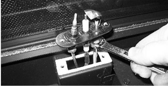
11. À l'aide d'une clé de 10 mm, retirez la conduite de gaz de la veilleuse et remplacez l'orifice de la veilleuse par celui fourni dans le kit de conversion. Assurez-vous que l'orifice de la veilleuse est bien en place et que la conduite de gaz de la veilleuse est correctement serrée pour éviter les fuites autour de l'orifice. S'il n'est pas correctement installé, cela provoquera une flamme pilote anormalement élevée.
