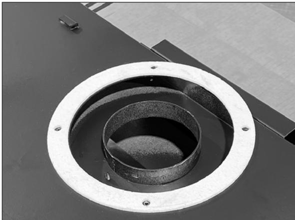
17. Alignez le tuyau intérieur du tuyau de départ de l'événement avec le tuyau de sortie d'évacuation sur le foyer. Le tuyau d'événement s'ajustera étroitement sur le tuyau du foyer. Poussez doucement le tuyau de démarrage sur le tuyau du foyer jusqu'à ce que l'extérieur la bride du tuyau entre en contact avec le tuyau de démarrage joint. Assurez-vous que les trous du tuyau de démarrage aligner la bride avec le joint et les avant-trous.
