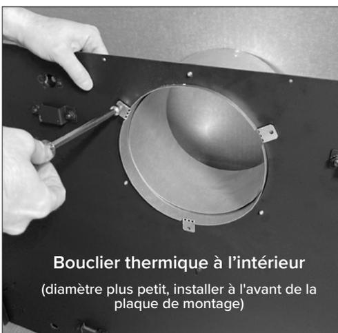
4. La moitié du bouclier thermique à l'extérieur (diamètre plus grand) est installée à l'arrière de la plaque. Glissez la moitié du bouclier à l'extérieur des-sus le bouclier à l'intérieur et alignez et installez les trois vis. Voir la photo ci-dessous.
