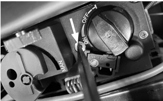
6. Avec le foyer réglé sur le niveau de flamme le plus bas, réglez la basse pression du collecteur en ajustant la vis Allen de 4 mm sur le côté inférieur de la valve. Reportez-vous au tableau ci-dessous pour les réglages de basse pression du collecteur qui varient selon le modèle de foyer.
