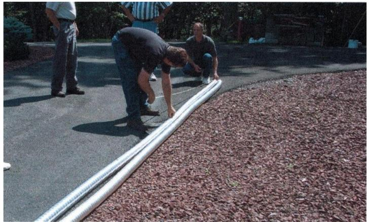
Dérouler la gaine aluminium de 3 pouces sur le sol et vérifier que vous avez une longueur suffisante de tuyaux. Identifier l'une des gaines aux 2 extrémités avec de la peinture et utiliser la pour l'évacuation. Une fois dans la cheminée, il sera plus facile d'identifier l'extrémité de l'entrée d'air et de l'évacuation.
